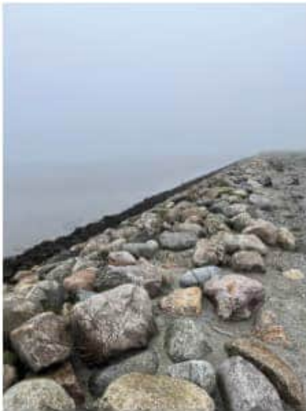
Figur 4-2. Princip for stenindfatning
